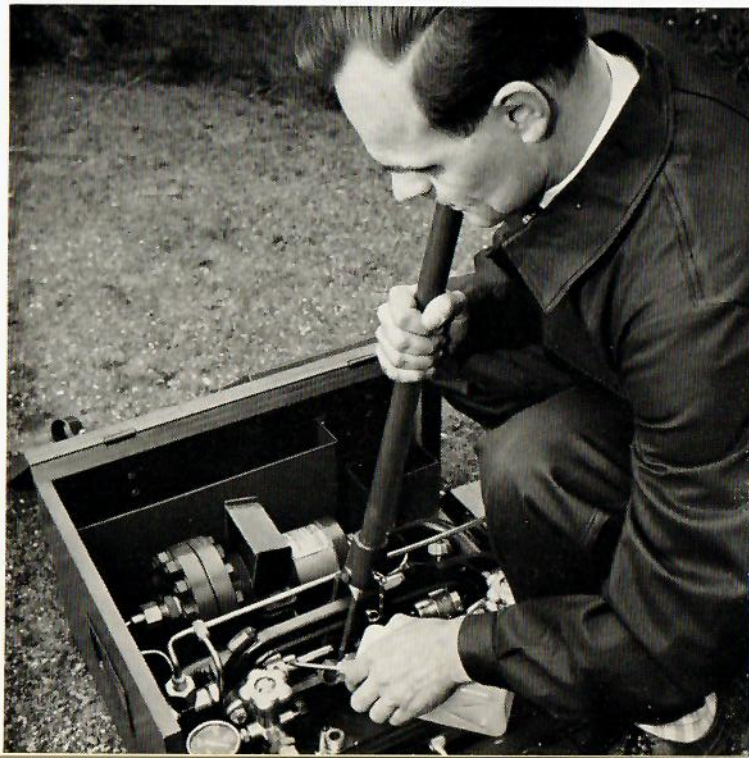
Abb. 12 Schmieren der Handumfüllpumpe mit Glyzerin-Wasser-Gemisch
